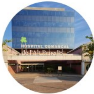
Hospital Comarcal de l'Alt Penedès
